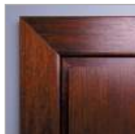
spojení obložkových lišt pod úhlem 45°
