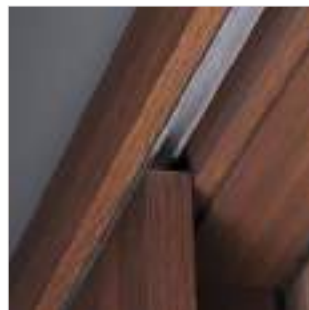
vedení nástěnného systému
