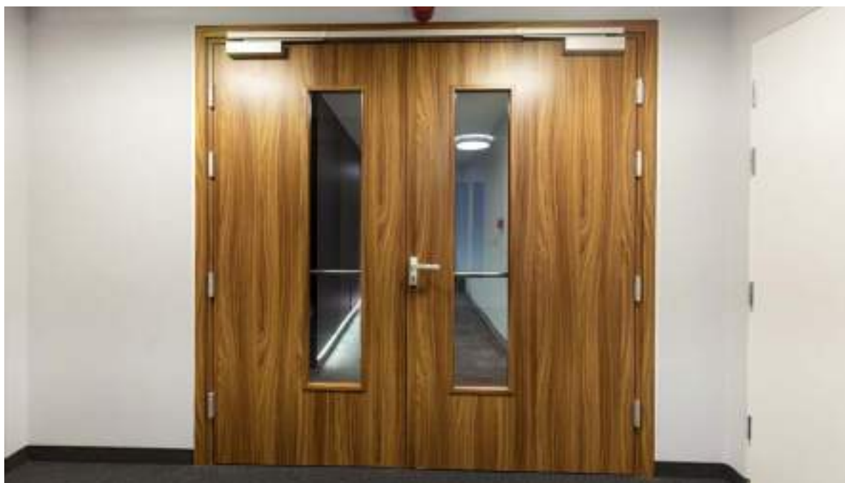
protipožární dveře FR EI30, pevná dřevěná zárubeň
