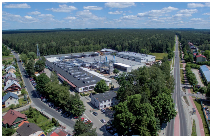
Továrna č. 3 a pila, Biłgoraj Factory No. 3 and sawmill, Biłgoraj Fabrik Nr. 3 und Sägewerk, Biłgoraj
